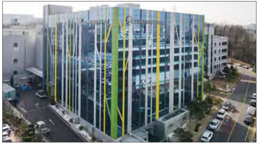
경기도 화성 씨앤씨인터내셔널 본사 및 제1공장 전경
